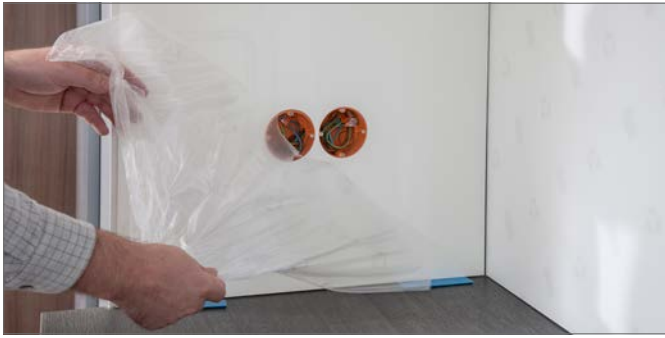
- Ziehen Sie nach der Kleberaushärtung die Schutzfolie ab
