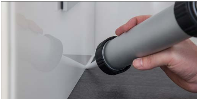
- Verfugen Sie die Fugen mit einem farblich passenden Silikon
